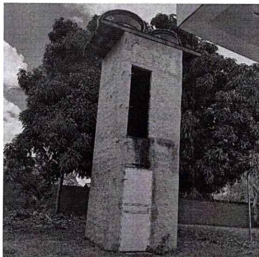
Estruturas do castelo d'água e fossa comprometidos
